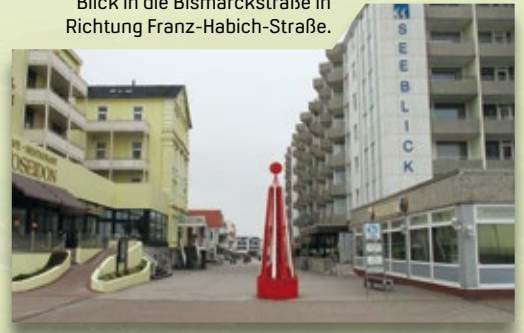
Blick zwischen die Fassaden: Die geplante Straße nimmt Gestalt an.
