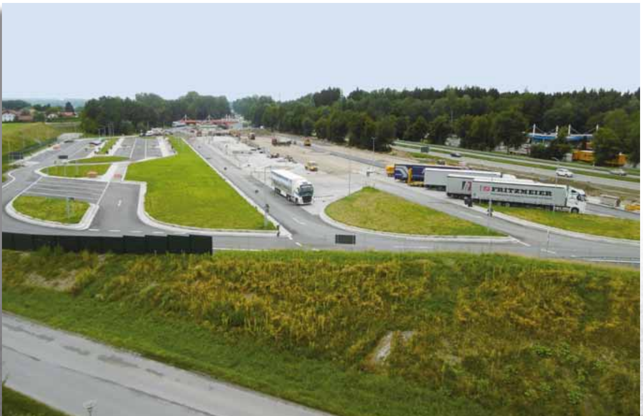
Abb. 1 – Blick auf die im Ausbau befindliche Tank- und Rastanlage Samerberg Süd an der A 8.
