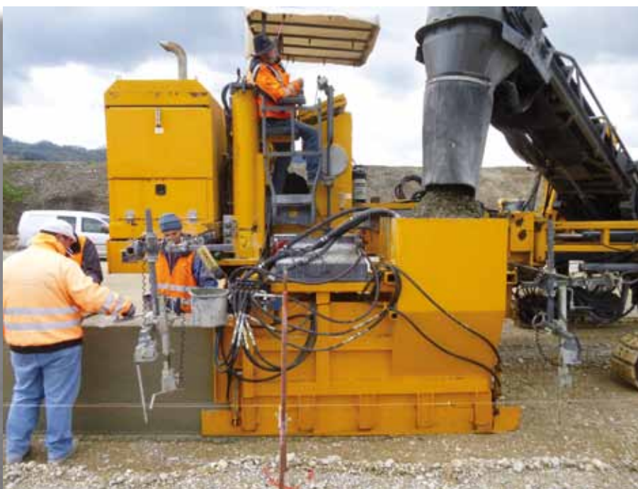
Abb. 6 - Gleitschalungsfertiger zur Erstellung der Betonprofile für die Hochbeete und Randeinfassungen ...
